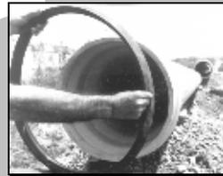
C) Limpieza de la campana y presentación del anillo empaque para determinar la posición correcta de colocación (el labio de diámetro mayor debe ser hacia fuera)
