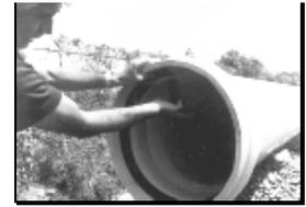
D) Colocación del anillo en el nicho de la campana. Se le da forma de "corazón" para insertarlo. Se debe presionar con suficiente fuerza la "onda" que se forma.
