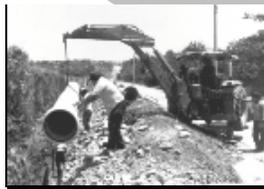
F) Una vez colocado el anillo, se baja la tubería a la zanja. Se puede hacer el bajón con cuerdas, colocando personal a ambos lados de la zanja.
